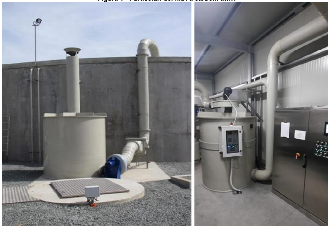
Figura 1 - Particolari dei filtri a carboni attivi
